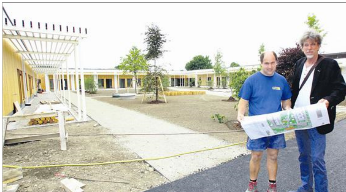
Überzeugten sich vom Baufortschritt beim Hilde Umdasch Haus (von links): Polier Thomas Farfeleder (Holz- und Bau GmbH) und Bauleiter Thomas Kuscher (Lottersberger Messner Architekten). Foto: Otmar Gartler
